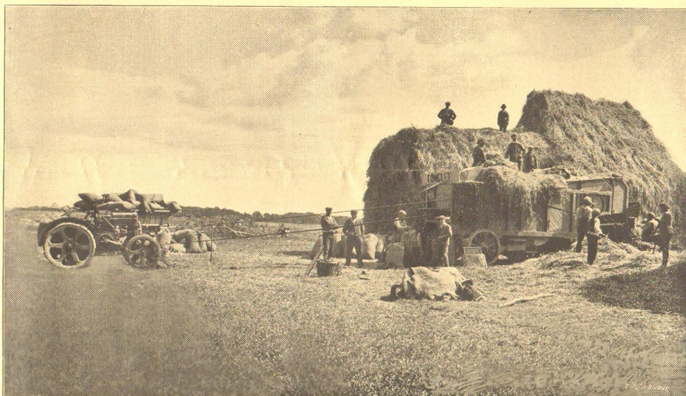
Batteuse et Botteleuse "TONGLET", actionnées par Tracteur "Case", au travail. - Modèle 22.
